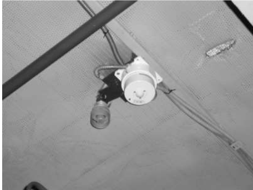
Рисунок 1.6 – Давач загазованості (зліва) і давач полум'я (справа)
