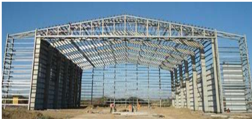
Рисунок 1.1- Сталева будівля рамно-зв'язкової конструкції на стадії будівництва
