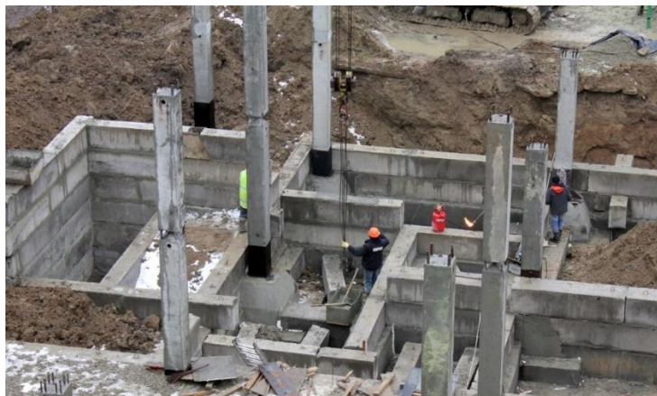
Рисунок 1.1 - Будівництво нового університетського гуртожитку НУЛП
