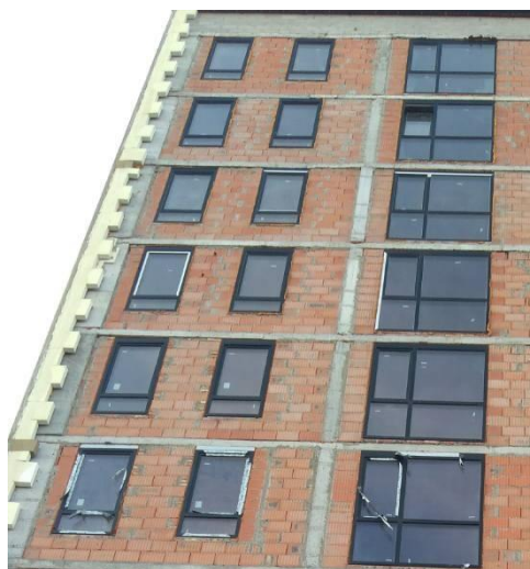
Рисунок 1.1 – Влаштування зовнішніх стін з керамоблоків
