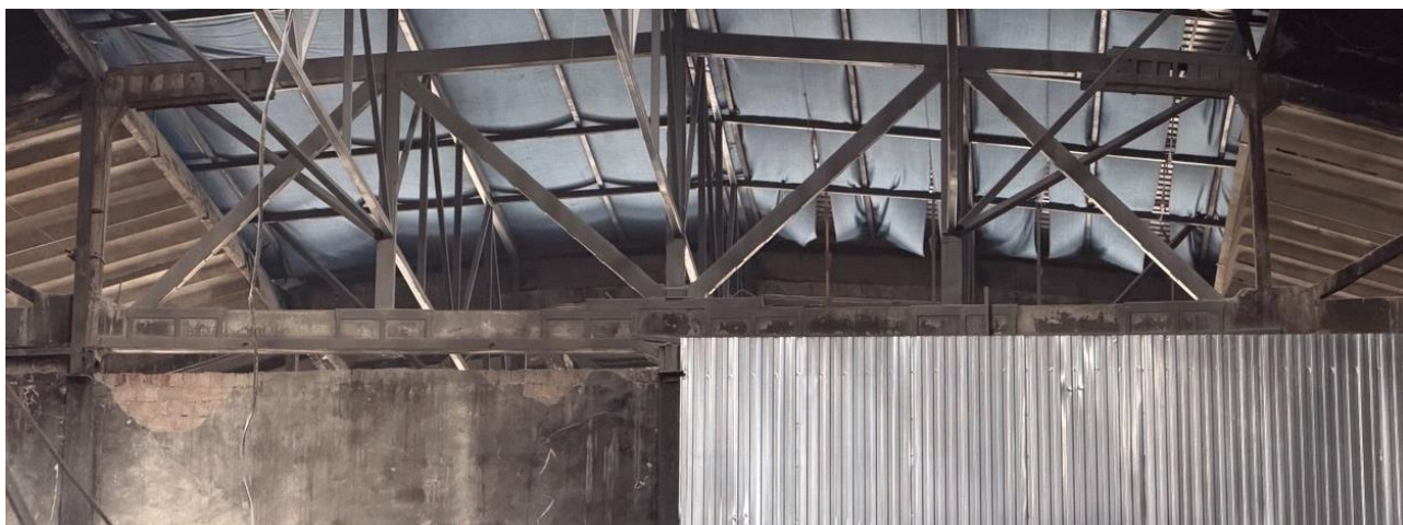
Рисунок 2.11 - Відновлена ферма по осі «15» прольоту «Є» - «Ж»
