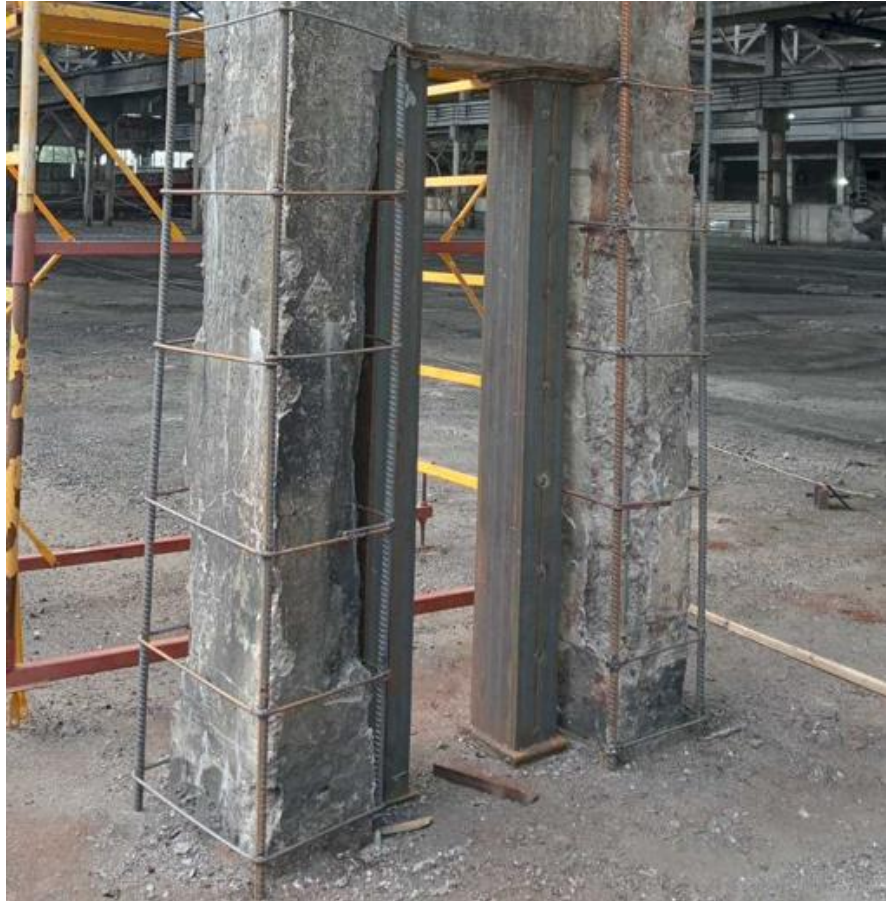
Рисунок 2.8 - Встановлення металевих стояків
