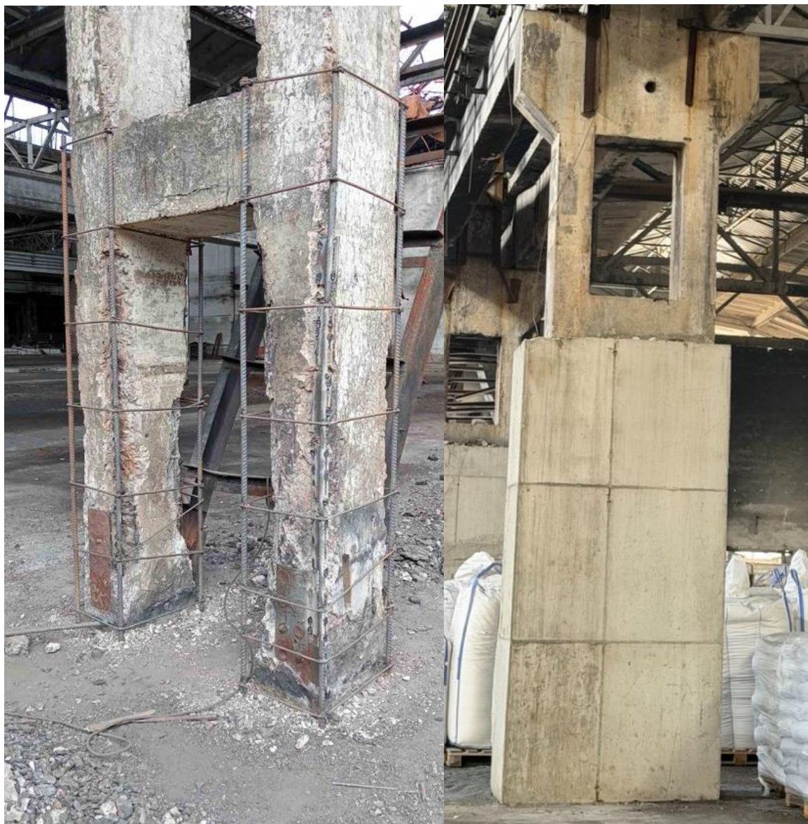
Рисунок 2.9 - Встановлення залізобетонних обійм
