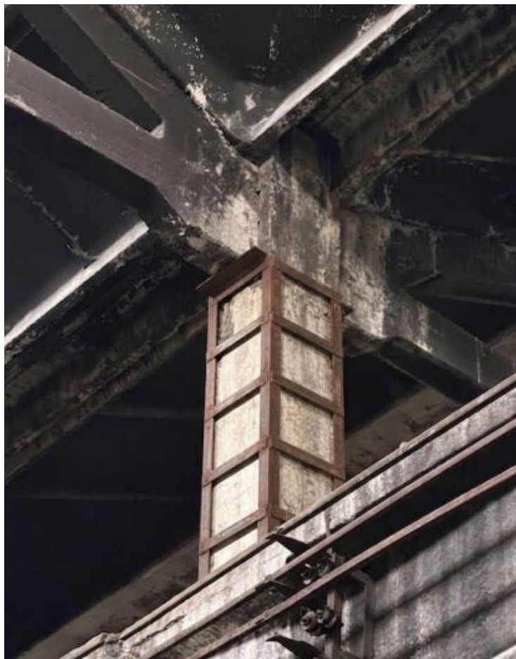
Рисунок 2.10 - Підсилення оголовка колони
