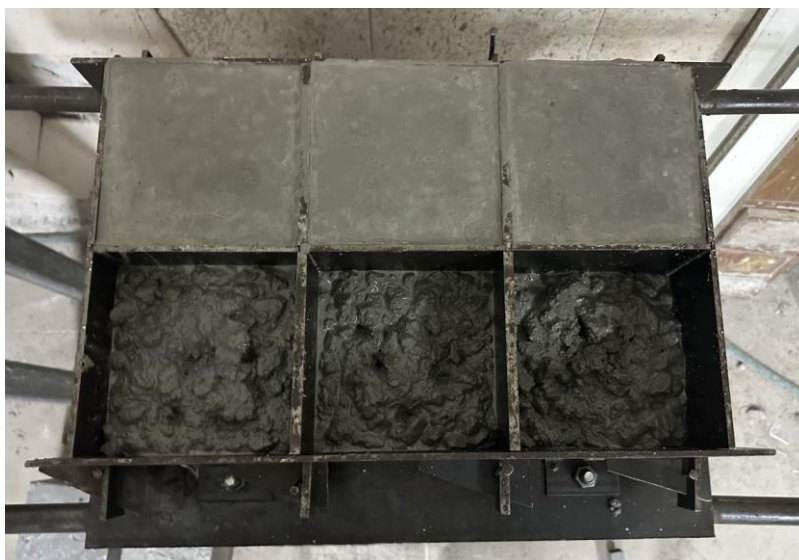
Рисунок 3.5 – Укладання бетонної суміші в форми
