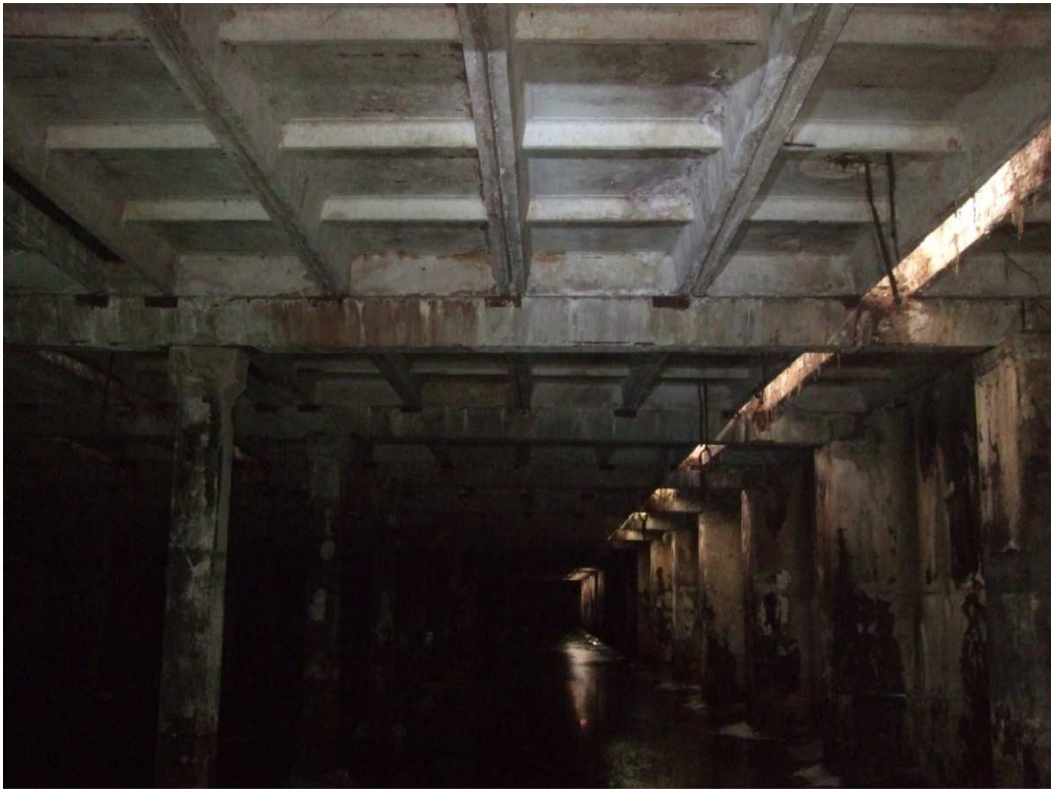
Рисунок 2.5 – Внутрішній простір підвального поверху будівлі корівника №4
