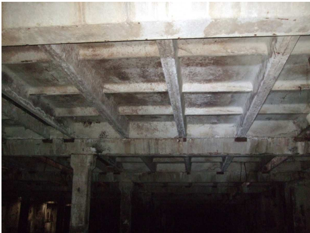
Рисунок 2.6 – Загальний вигляд збірного залізобетонного надпідвального перекриття
