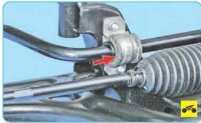
Рисунок 2.12 Перевірка стану втулок стабілізатора поперечної стійкості.
