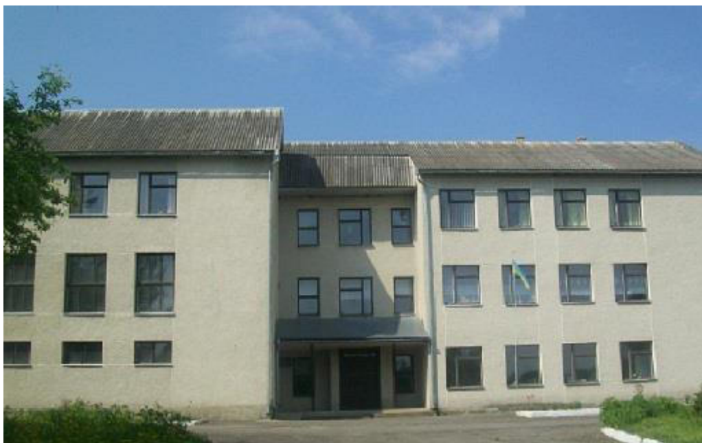
Рисунок 1.1 – Будівля Іванковецького ЗЗСО
