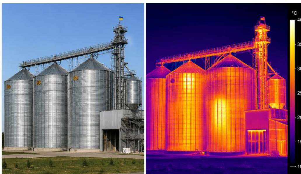
Рисунок 3.10 – Фотографії елеватора у видимому та тепловому спектрі
