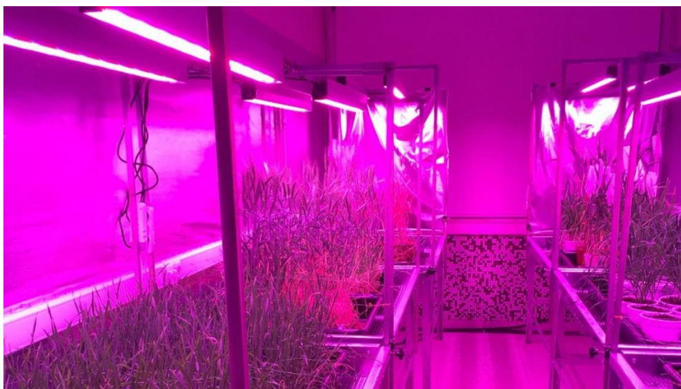
Рисунок 1.3 – Багатоярусна стелажна система з програмованим фітоосвітленням
