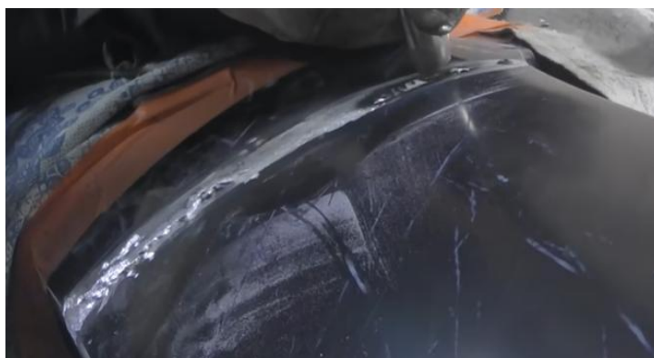
Рисунок 1.8 – Виконання MIG/MAG-зварювання кузовної деталі автомобіля
