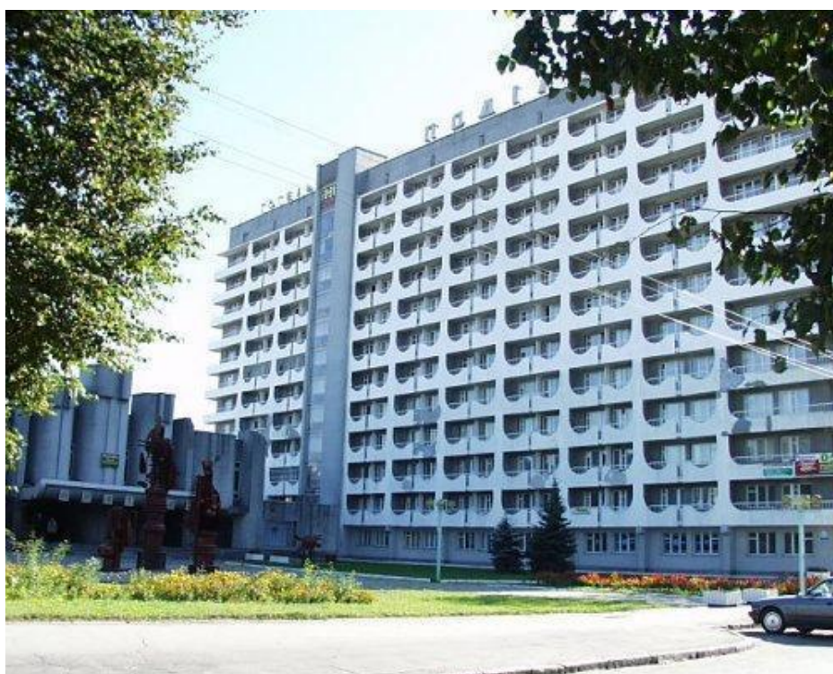
Рис. 2.1. Будівля готелю «Поділля»
