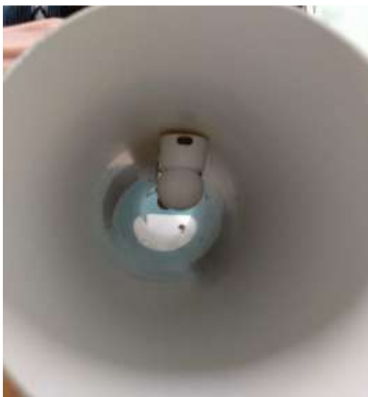
Рисунок 3.4 – Встановлення ультрафіолетової лампи у трубу
