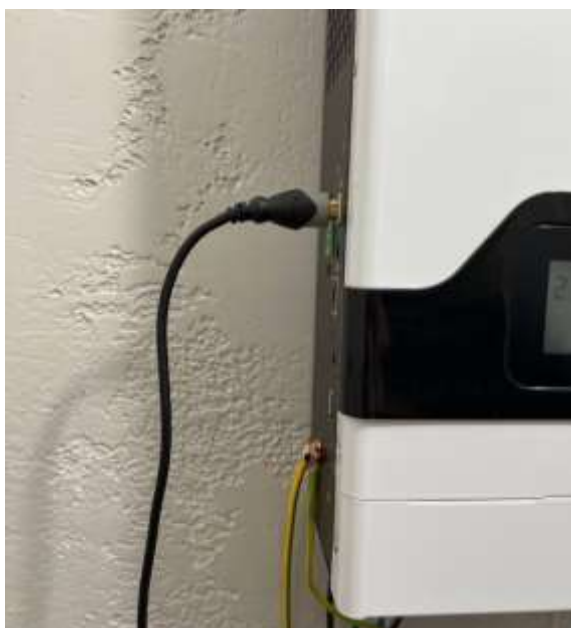
Рисунок 1.2 – Підключення інвертора Must через USB
