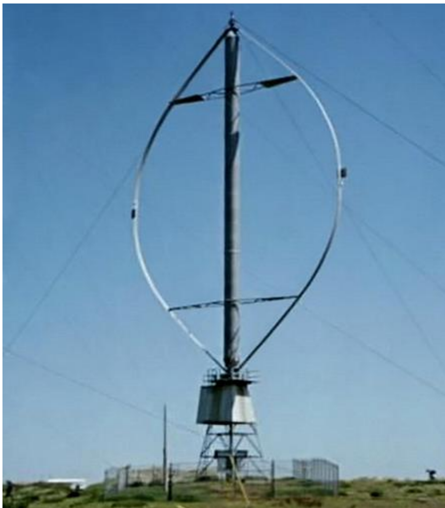
Рисунок 1.13 - загальний вигляд ротора Дар'є.
