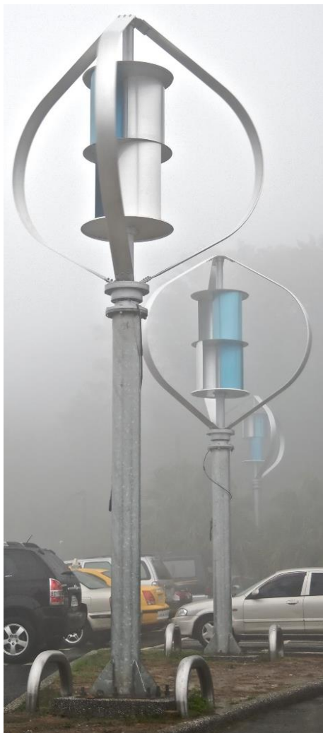
Рисунок 1.12 - Загальний вигляд ротора Савоніуса, об'єднаного з турбіною Дар'є
