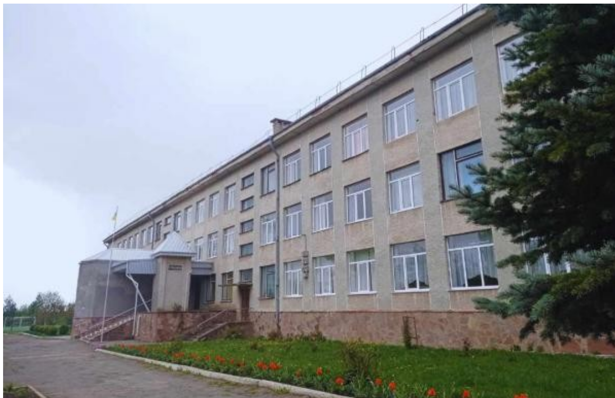
Рисунок 1.1. Загальне зображення будівлі Дружбівського ЗЗСО I-III ступенів
