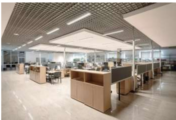
Рисунок 1.2 – Розташування світильників в системі загального рівномірного освітлення адміністративного приміщення
