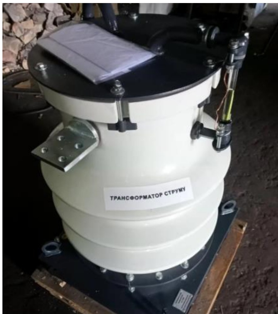
Рисунок 3.5 - Загальний вигляд ТФЗМ-35А-У1
