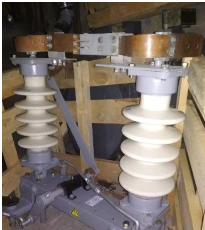
Рисунок 3.8 - Загальний вигляд РНД-35/1000 У1.
