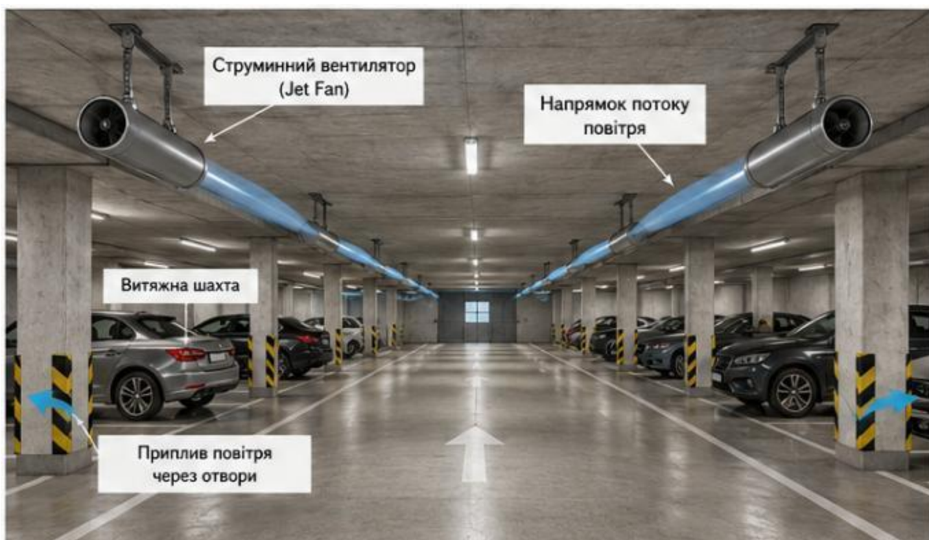
Рисунок 1.3 – Струминна система вентиляції підземного паркінгу
