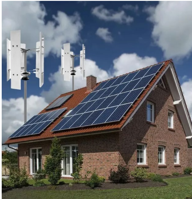
Рисунок 2.1 – Загальний вигляд об'єкта дослідження (приватний будинок площею 350 м 2 )
