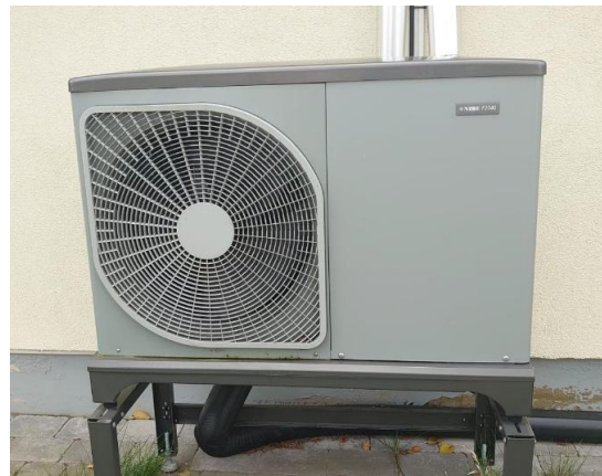
Рисунок 2.6 - Система теплового насоса NIBE F2050-6KW
