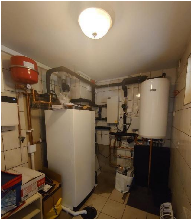
Рисунок 2.6 - Система теплового насоса NIBE F2050-6KW
