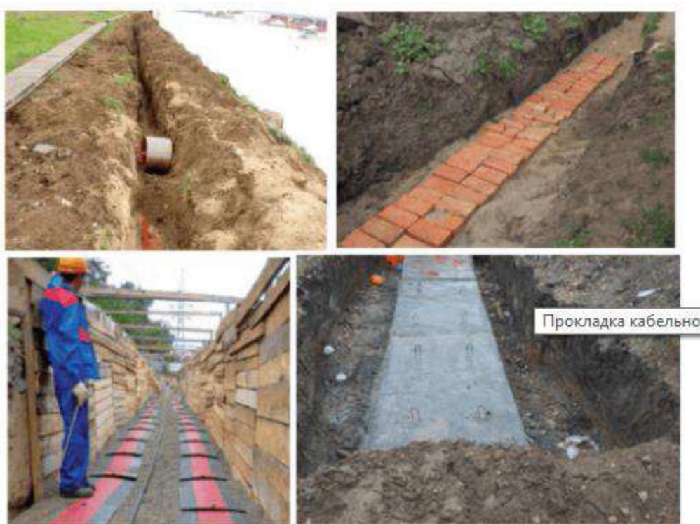
Рисунок 3.2 – Способи захисту кабельних ліній.
