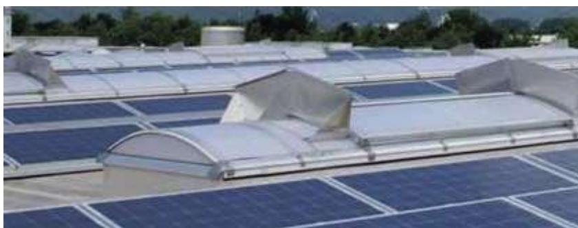
Рисунок 2.11 – Виконання зенітних світлових отворів у даху центру
