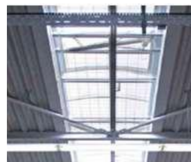
Рисунок 2.11 – Виконання зенітних світлових отворів у даху центру
