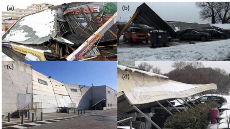
Рисунок 1. Обвали дахів, спричинені сильними снігопадами 2018 року в районі Монпельє, Франція (Відтворено з Back analysis of a building collapse under snow and rain loads in a Mediterranean area , I. Ousset, G. Evin, D. Raynaud, & T. Faug, 2023, (Natural Hazards and Earth System Sciences, 23(11), Fig. 1). Первинне авторство фото: (a) © Jean-Michel Mart; (b) © Le Petit Journal de Lattes; (c) © France 3 LR / Sébastien Banus; (d) © France 3.)
