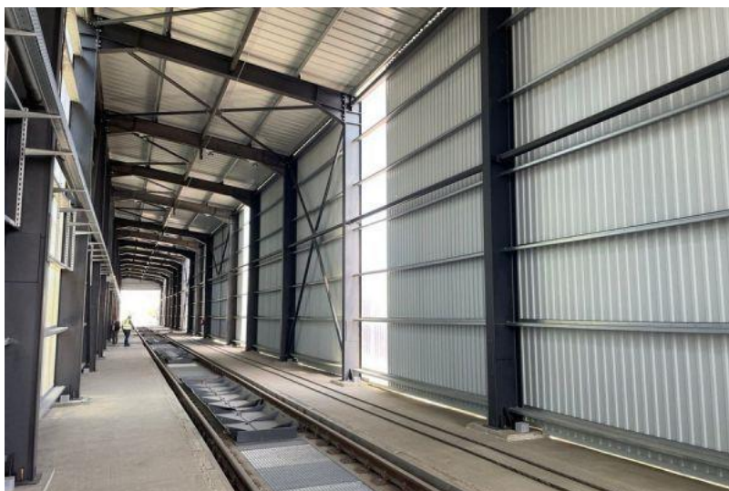
Рисунок 1.2 - Накриття станції розвантаження залізничних вагонів
