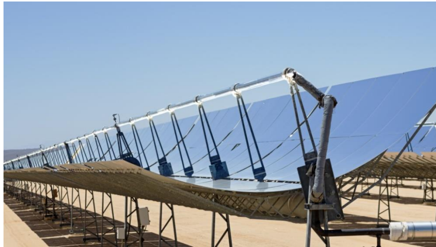
Рисунок 1.3 - Застосування одноосової системи стеження за сонцем для сонячної теплової параболічної труби
