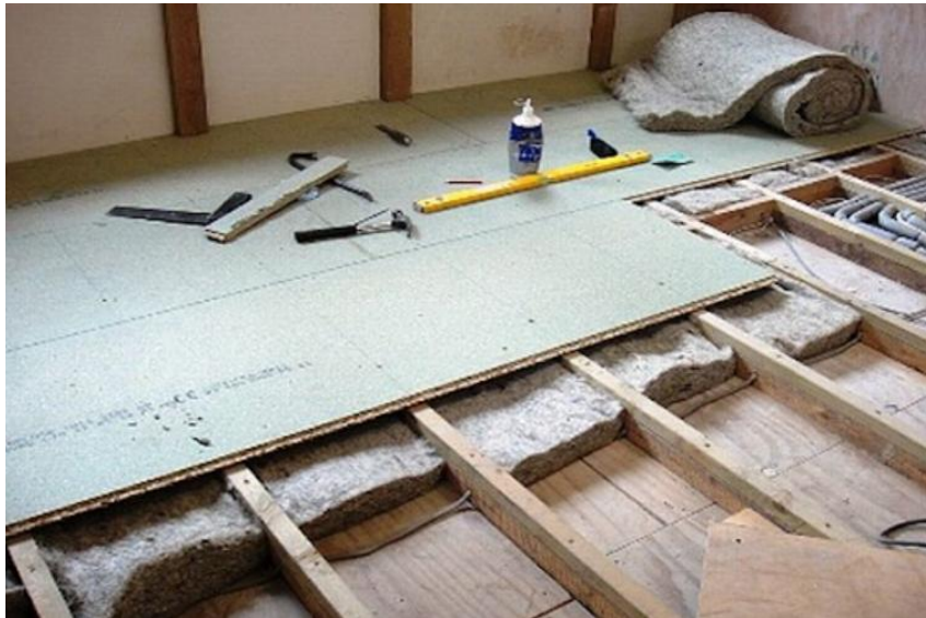
Рисунок 2.6 – Утеплення мансардного приміщення базальтовою ватою
