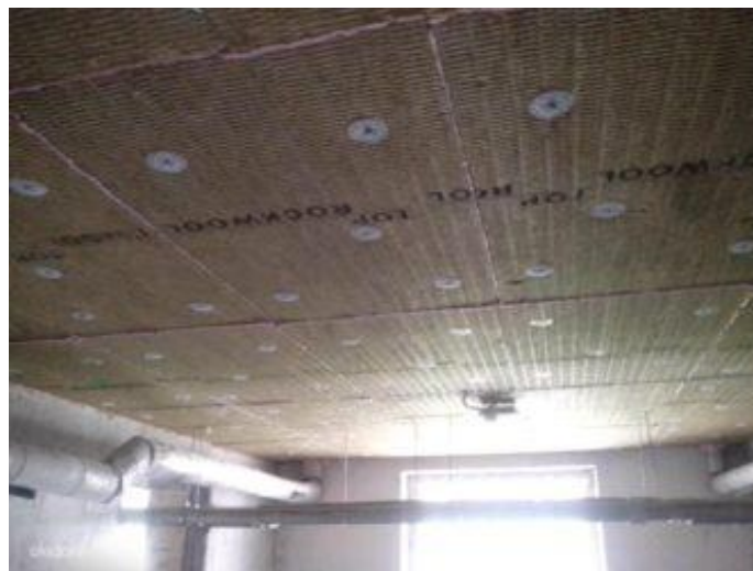
Рисунок 2.5 – Утеплення стелі підвального приміщення пінополістирольними плитами
