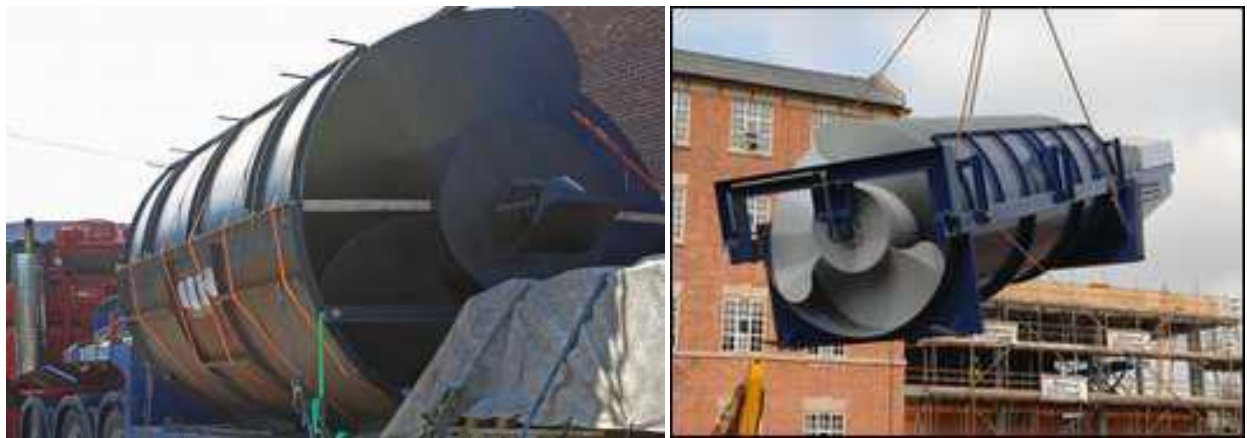
Рисунок 2.8 – Монтаж лопатей ГТА, можливо, для зниження рівня шуму
