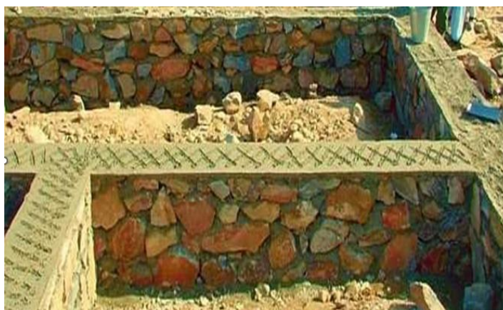
Рисунок 1.4 – Бутобетонний стрічковий фундамент
