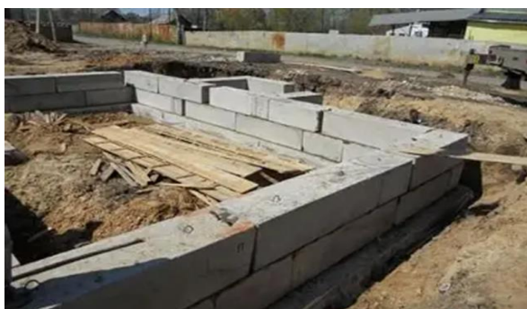
Рисунок 1.7 – Стрічковий збірний фундамент із залізобетону
