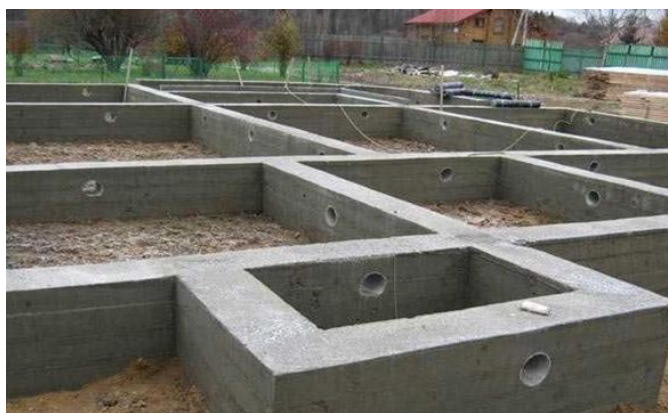
Рисунок 1.6 – Монолітний залізобетонний стрічковий фундамент
