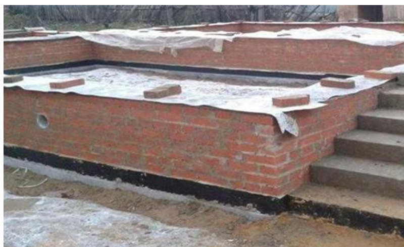
Рисунок 1.5 – Цегляний стрічковий фундамент
