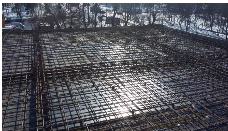
Рисунок 4.4 – Бетонування монолітного міжповерхового перекриття
