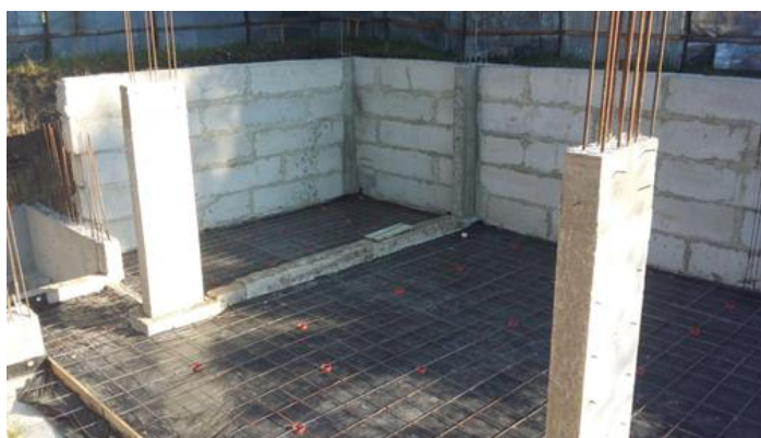
Рисунок 4.1 – Бетонування фундаменту
