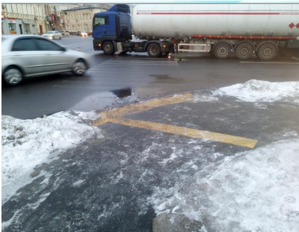
Рис. 2. Тактильна розмітка, яка виводить незрячого на перехрестя замість переходу
