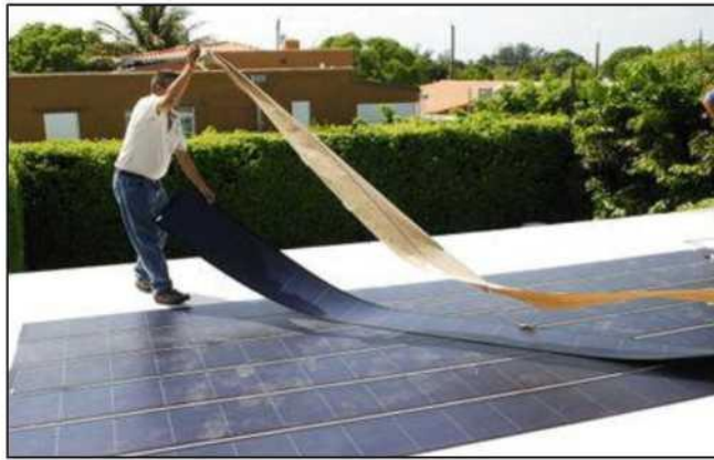
Рисунок 1.3 – Некристалічний кремній розміщений на гнучкому матеріалі для формування тонкоплівкової комірки.
