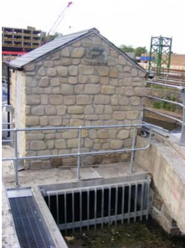
Рисунок 1.6 - Вхідна сторона установки гвинта Архімеда
