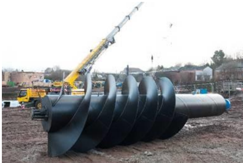
Рисунок 1.5 - Корпус гвинта Архімеда перед установкою
