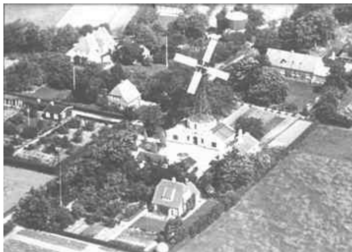
Рисунок 1.4 -Турбіна La Cour Lykkegard, розміщена на будівлі.
