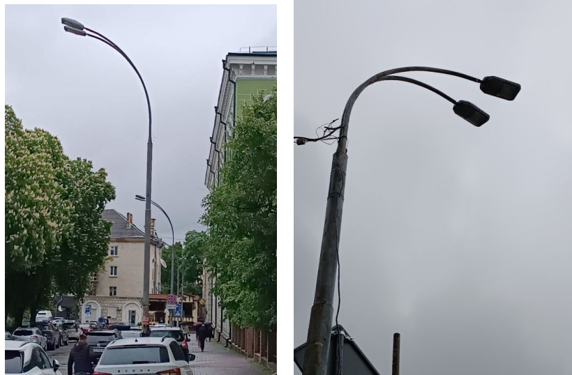
Рисунок 2.6 – Світильники в системах освітлення смуг руху автомобільного транспорту
