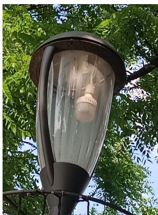
Рисунок 2.10 – Зображення світлових приладів зі світлодіодною лампою для освітлення пішохідних доріжок частини IV Майдану
