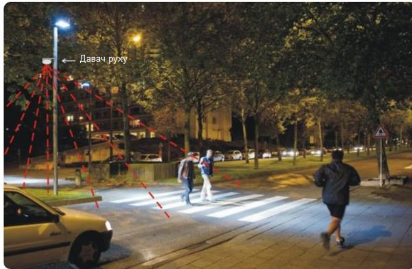
Рисунок 2.3 – Датч руху на стовпі з ліхтарем
