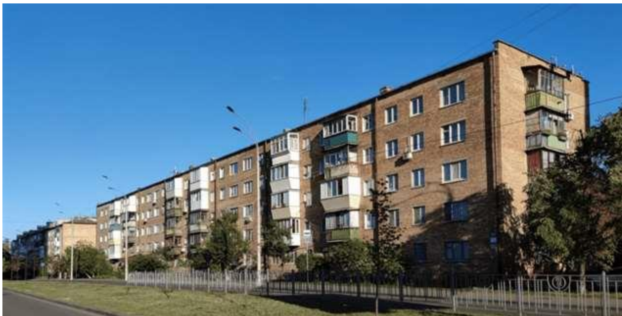
Рисунок 1.4 – Загальний вигляд типового п'ятиповерхового будинку
