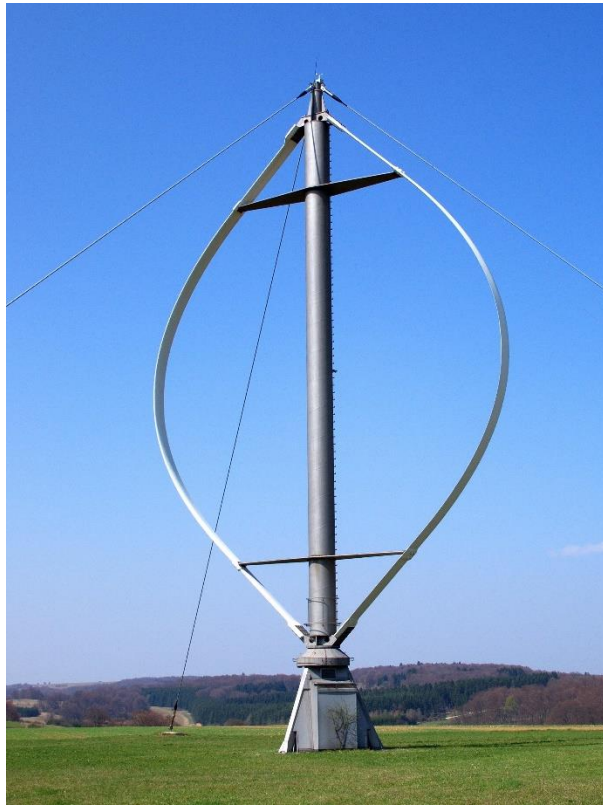
Рисунок 1.3 - Вітрогенератор типу Дар'є
