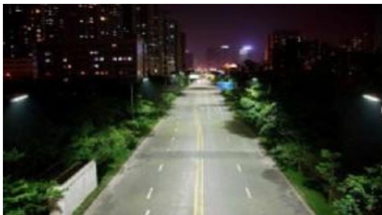
Рисунок 1.9 – Освітлення багатополосної автомагістралі за допомогою світлодіодних світильників
