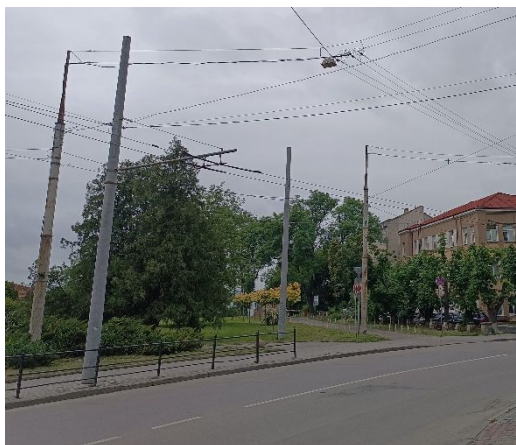
Рисунок 2.10 – Нововстановлені опори СК 120-10 вулиці Замкова
