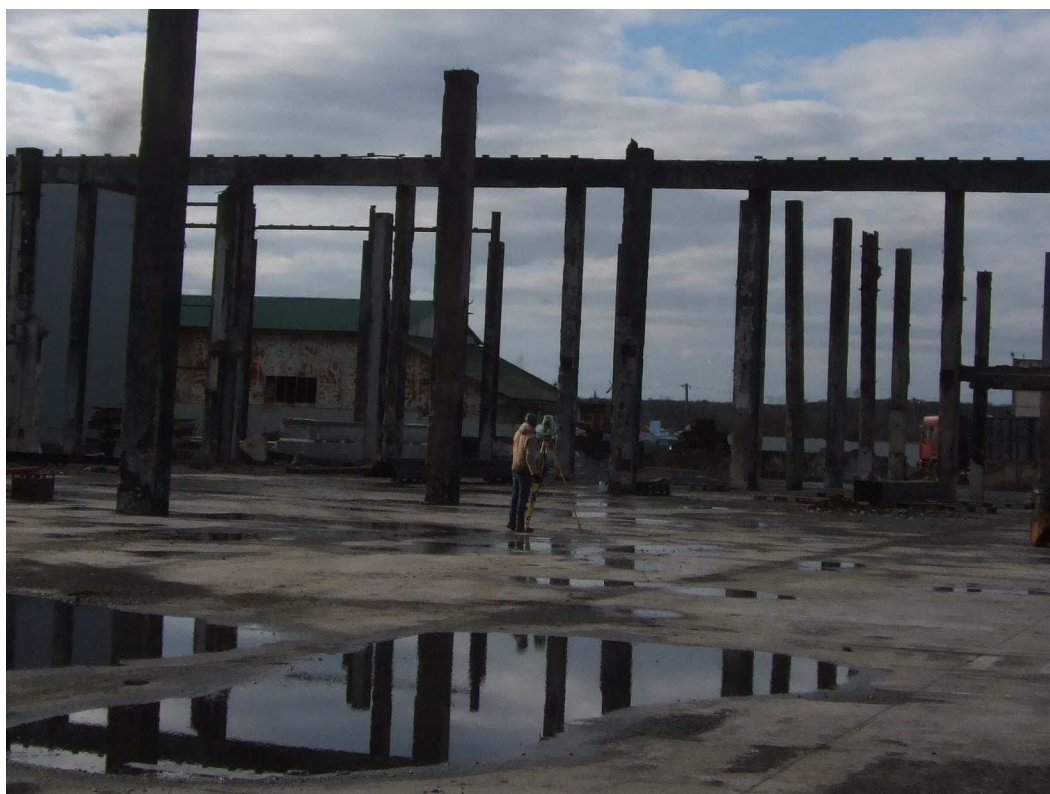
Рисунок 2.5 – Інженерно-геодезичні вимірювання відхилення збірних залізобетонних колон від вертикалі
