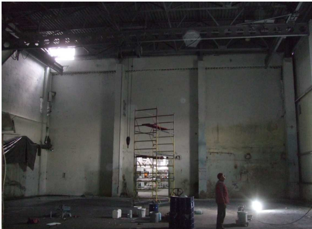
Рисунок 2.6 – Збірні залізобетонні колони, що не контактували з вогнем та підлягали інструментальним дослідженням
