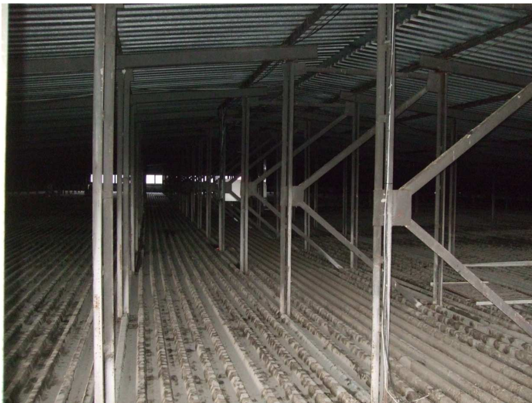
Рисунок 2.2 – Загальний вигляд горища, що утворилось після зміни конструкції даху будівлі з плоского суміщеного на шатровий двоскатний
