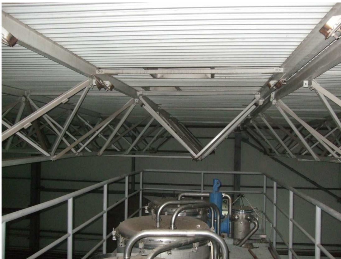
Рисунок 2.9 – Місце демонтовану нижнього поясу структурного блоку
