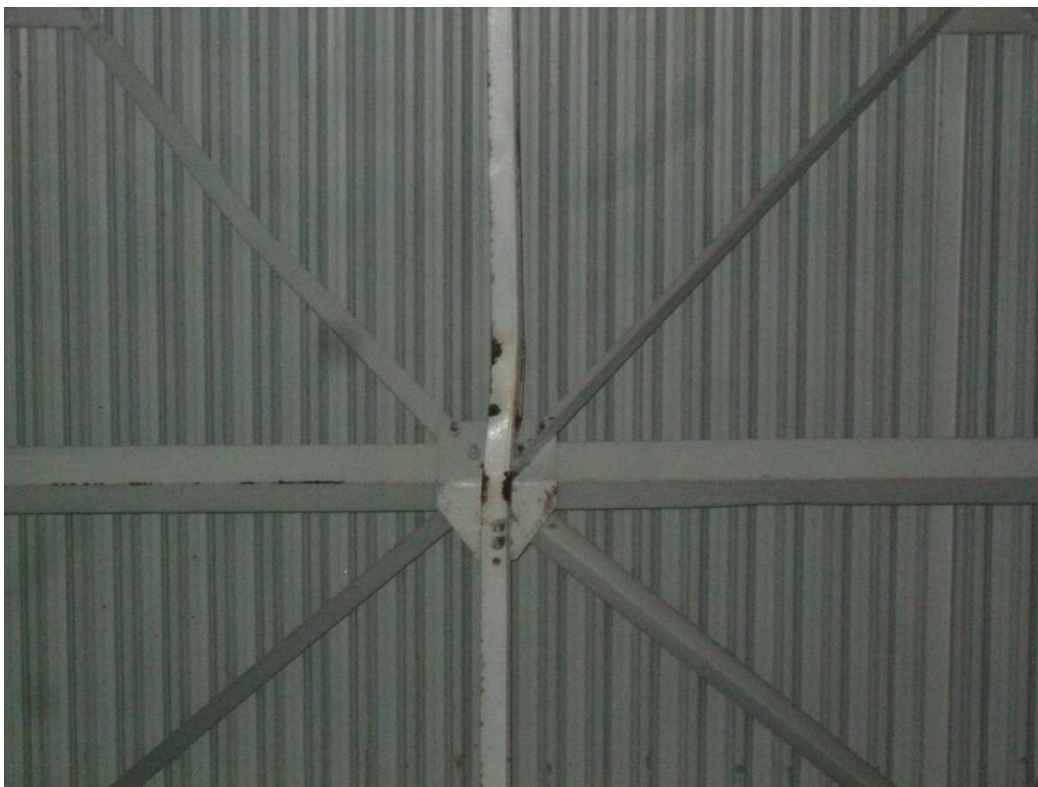
Рисунок 2.10 – Місце деформування розпірки структурного блоку в результаті механічного впливу
