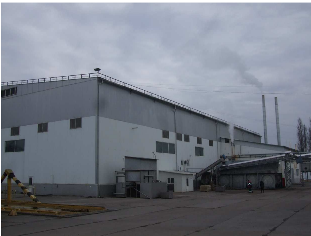
Рисунок 2.1 – Загальний вигляд будівлі цеху по виготовленню сокових концентратів під літ. «Б», що підлягав технічному обстеженню
