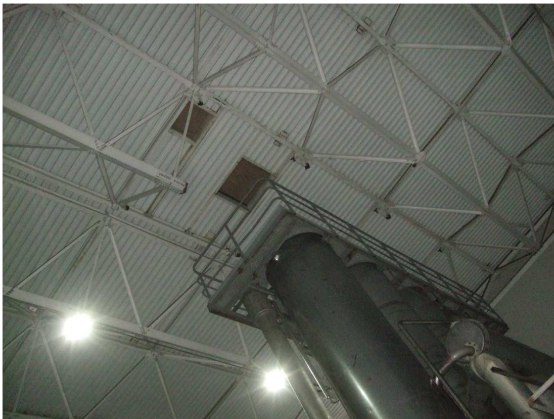
Рисунок 2.8 – Структурний блок, що містить демонтований нижній пояс
