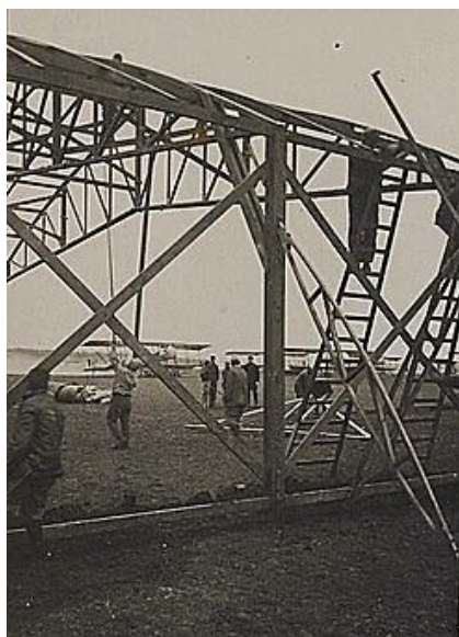
Рисунок 1.1 - Монтаж ангару системи "Бессоно"[5]
