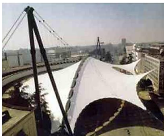
Рисунок 1.11 - Підвісне покриття з поздовжньою вантовою системою, Мілан, Італія [8]
