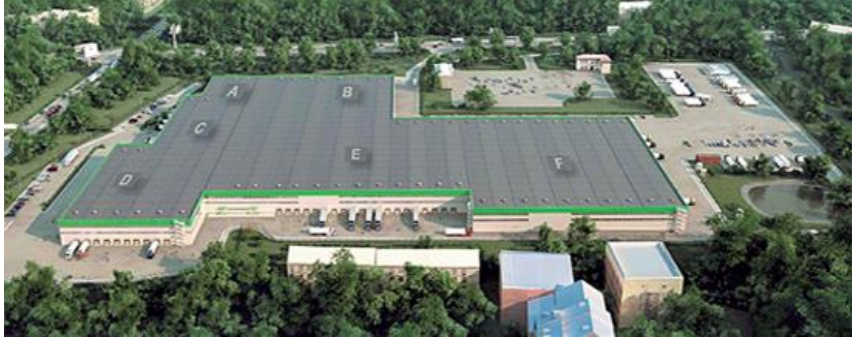
Рисунок 6.10 – Загальний вигляд складського логістичного комплексу "Комодор"
