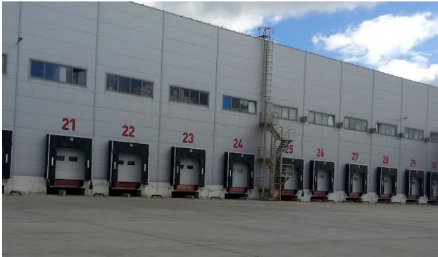
Рисунок 6.7 – Загальний вигляд логістичного центру "West Gate Logistic"
