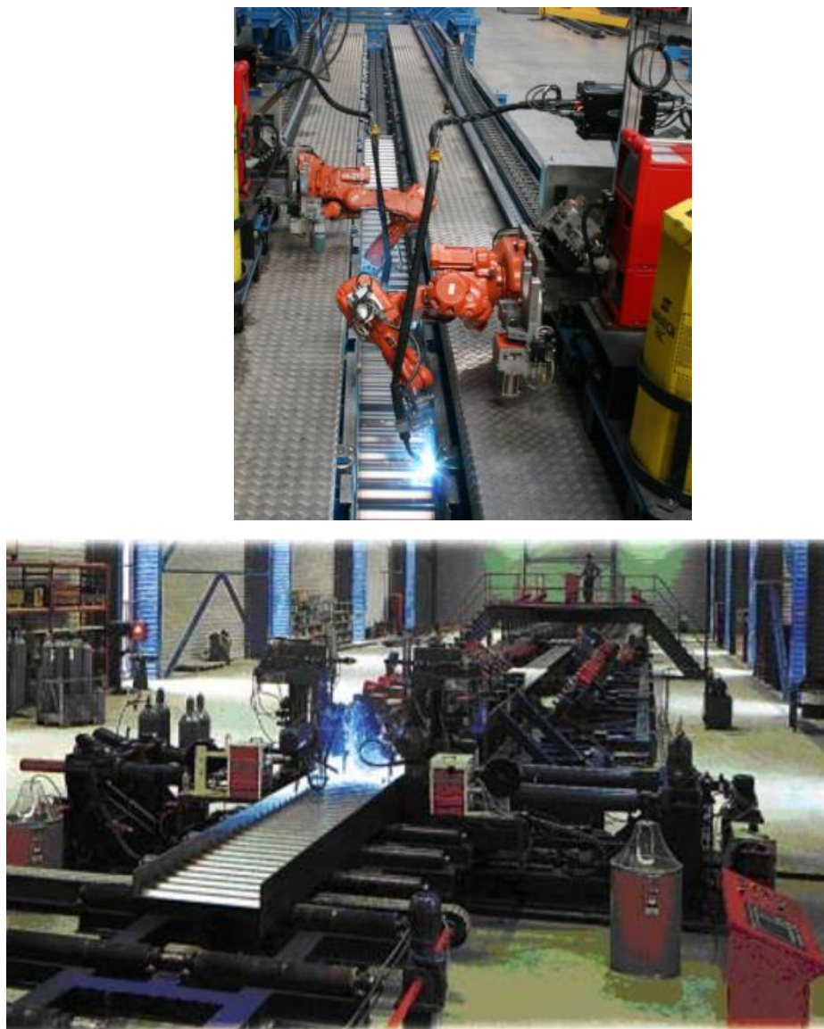
Рис. 1.3 – Процес зварювання гофрбалки
