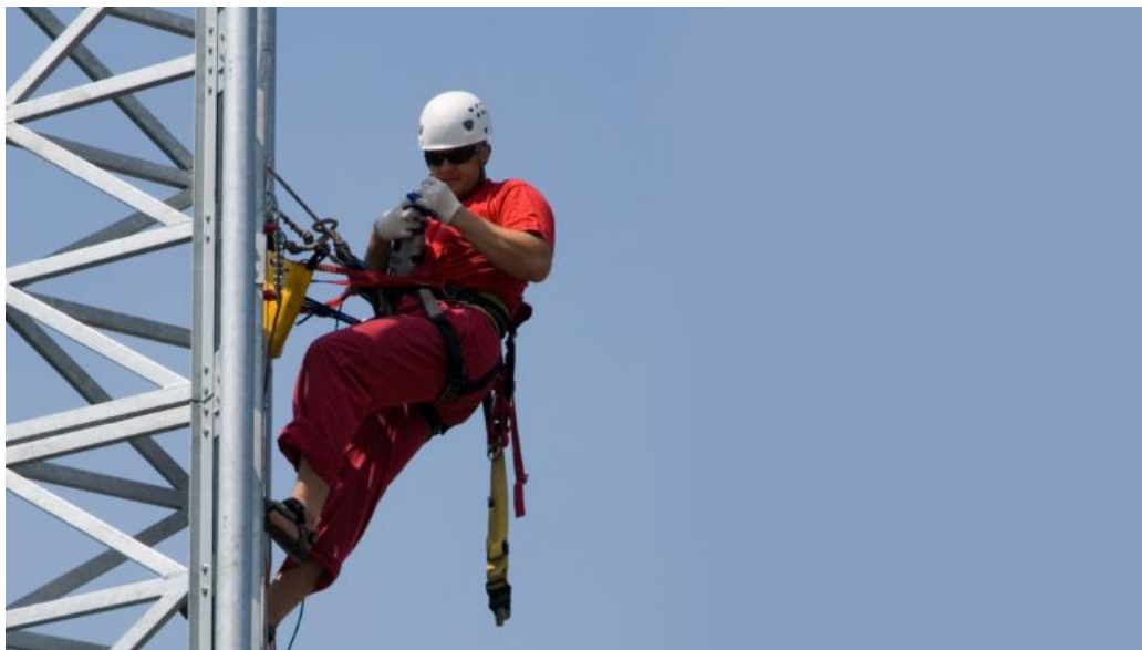
Рис. 4.2. Монтаж антенно-рефлекторної системи на висоті: забезпечення безпеки працівників під час робіт.
