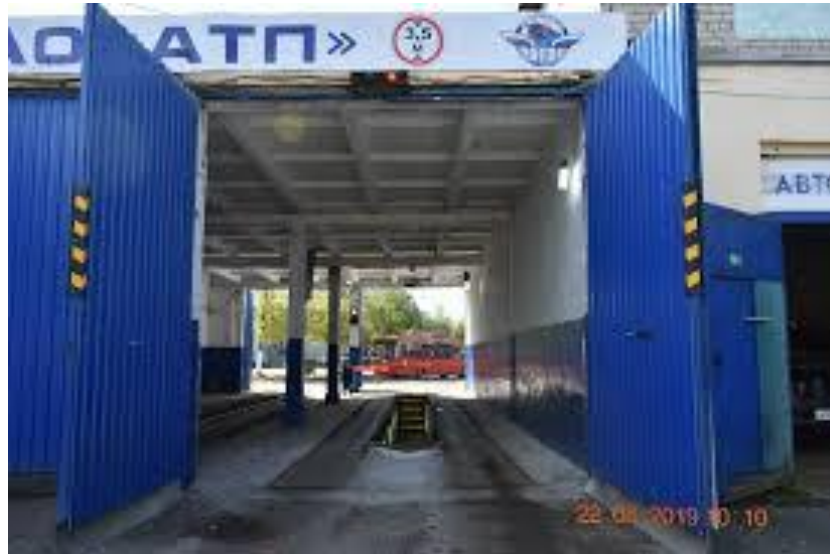
Рисунок 2 - Контрольно-технічний пункт АТП.
