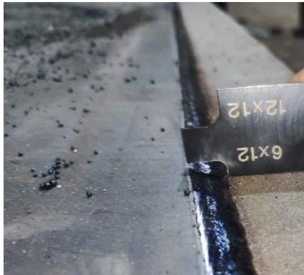
Рисунок 4.3 Зварні шви після автоматичного зварювання
